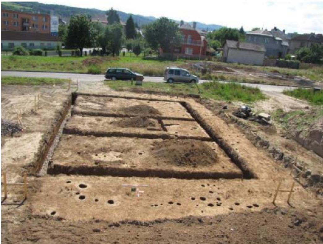
Zábřeh – Květinová, pohled na základy RD a vyexcavované objekty od východu.
