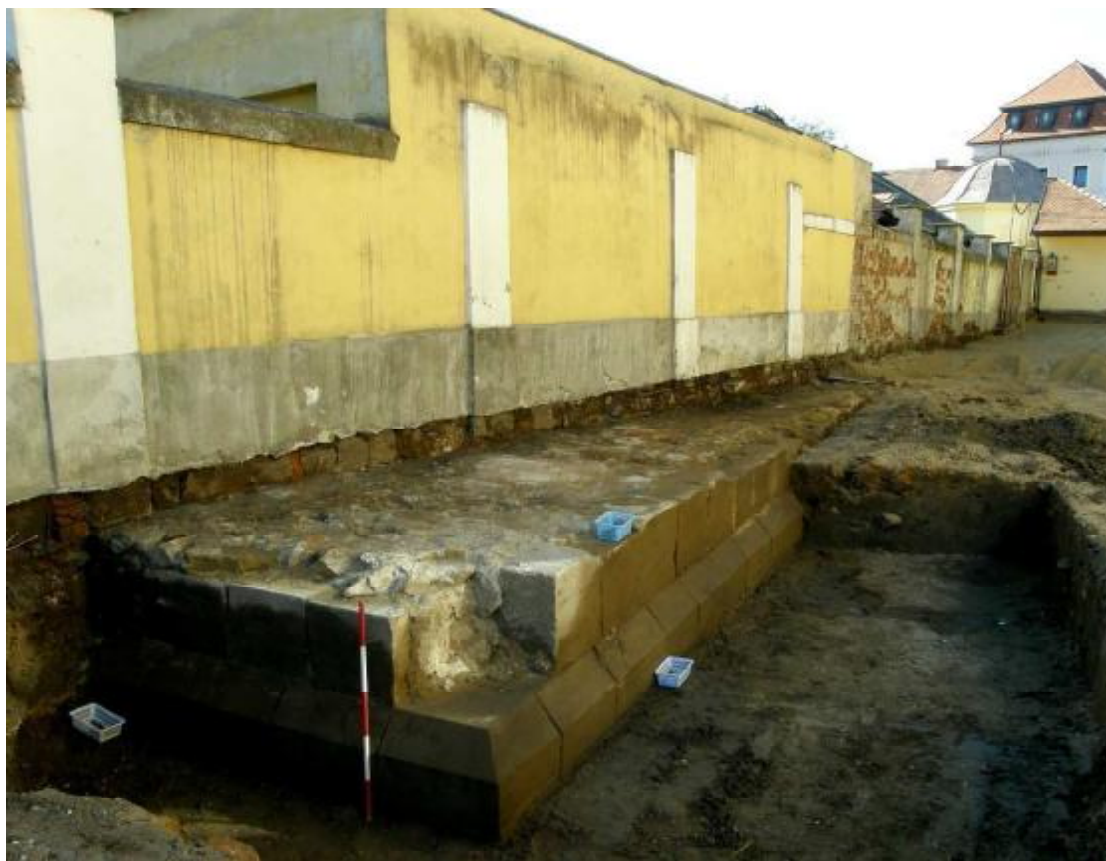
Pohled od severovýchodu na odkryté nároží a nadzemní zdivo hranolové věže.
