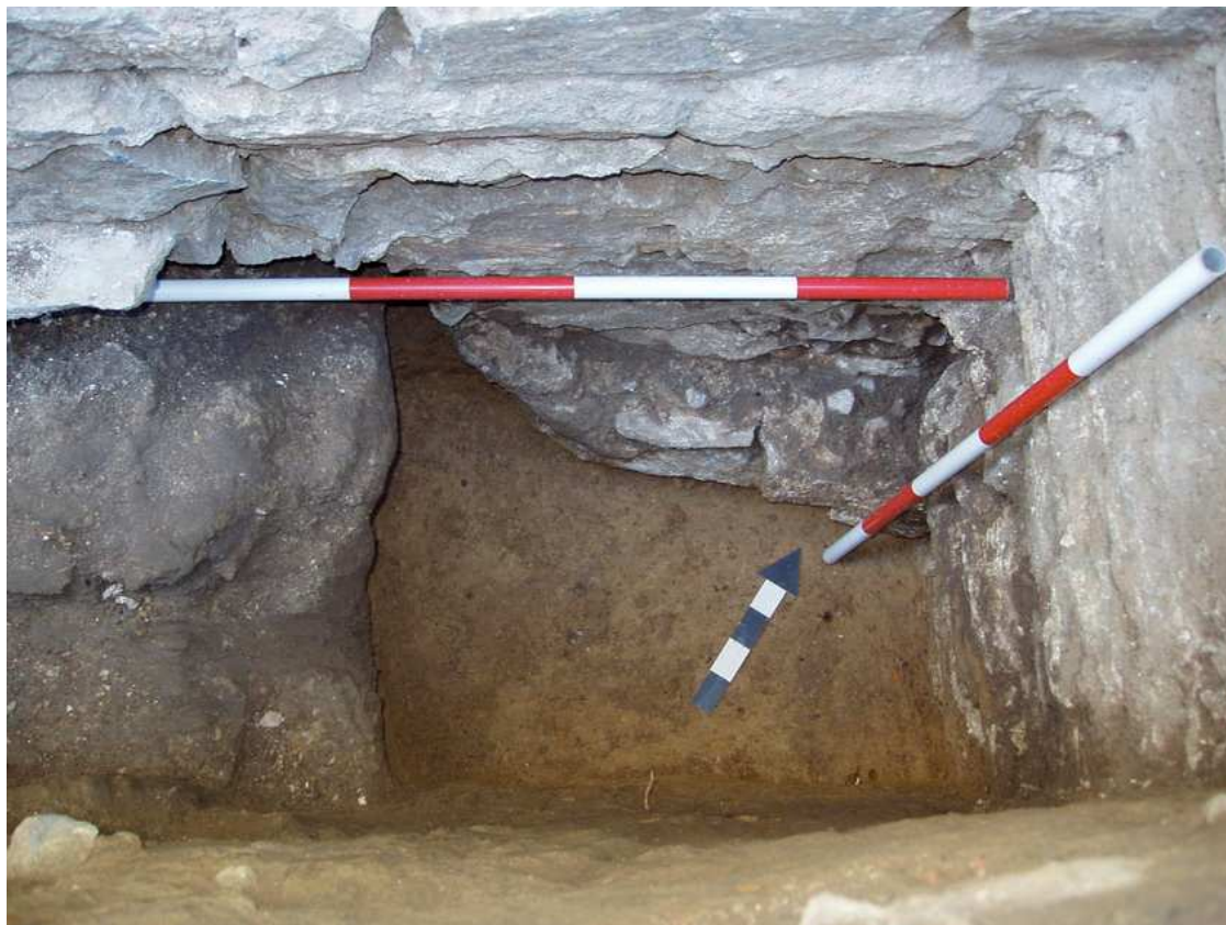
Obr. 10: Přerov-Předmostí: Zdivo odkryté pod severním vnitřním nárožím základů věže a hlavní lodi kostela sv. Máří Magdalény.
